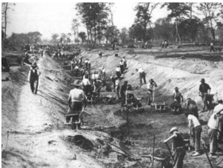
Realizzazione di un canale raccolta acqua
