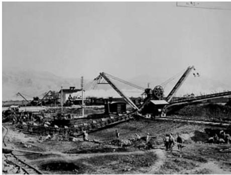
Lavori di bonifica
