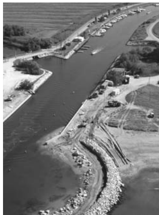
Lavori a Rio Martino
