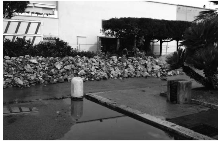
Lavori in Piazza ...
