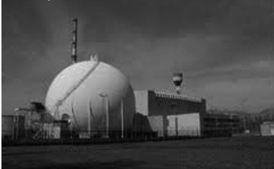
Centrale di Borgo Sabotino
